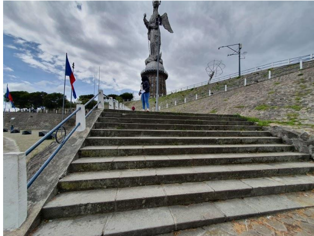
Imagen No. 5. Escaleras frontales al atractivo. Fuente: Estefanía Pastas, 2021.
