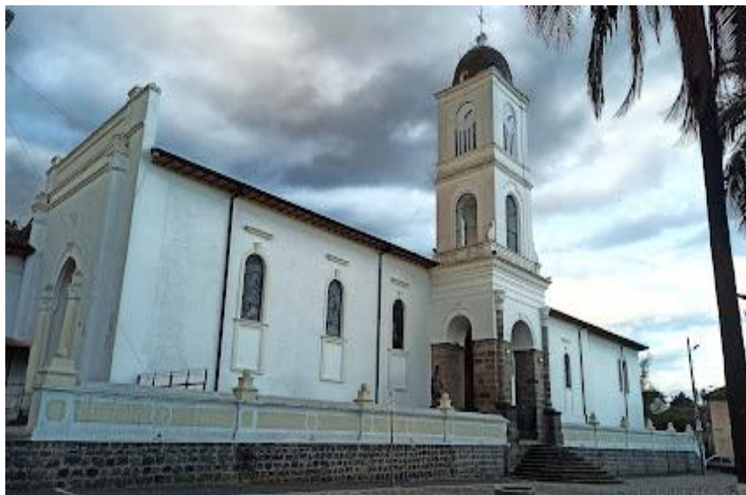
Figura 12. Iglesia de Amaguaña
