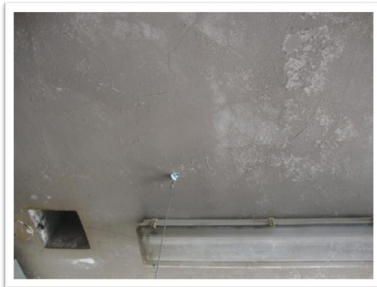
Imagen 3.9. Techo en mal estado. Taller 4. Fuente: UNIBE. Lenin Vaca, 2012
