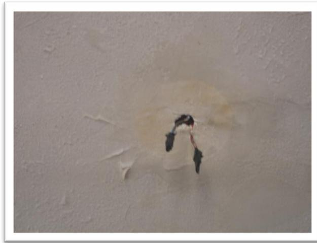
Imagen 3.2. Conexiones eléctricas expuestas Taller 4. Fuente: Lenin Vaca, 2012.
