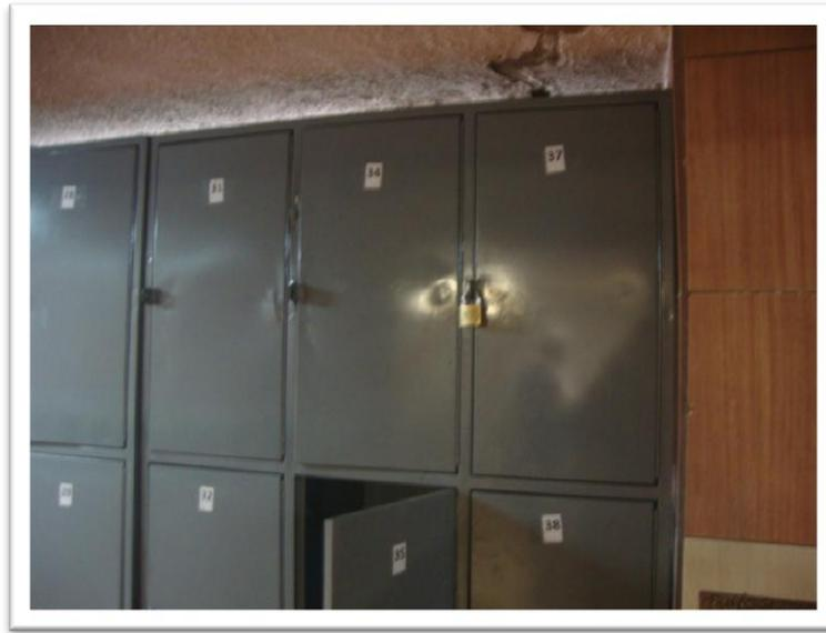
Imagen 3.11. Falta de salida de emergencia bloqueada por casilleros Talleres 2 y 3.
