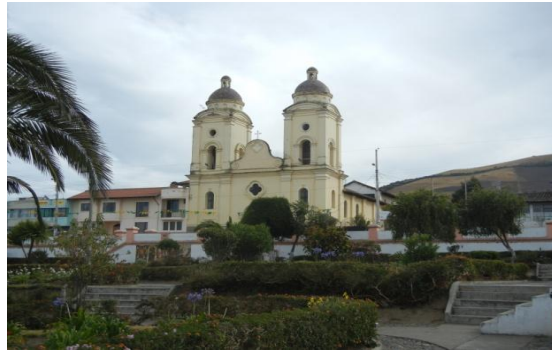
Fotografía No. 5 Parque Central de Malchingui Fuente: Parroquias rurales de Pichincha
