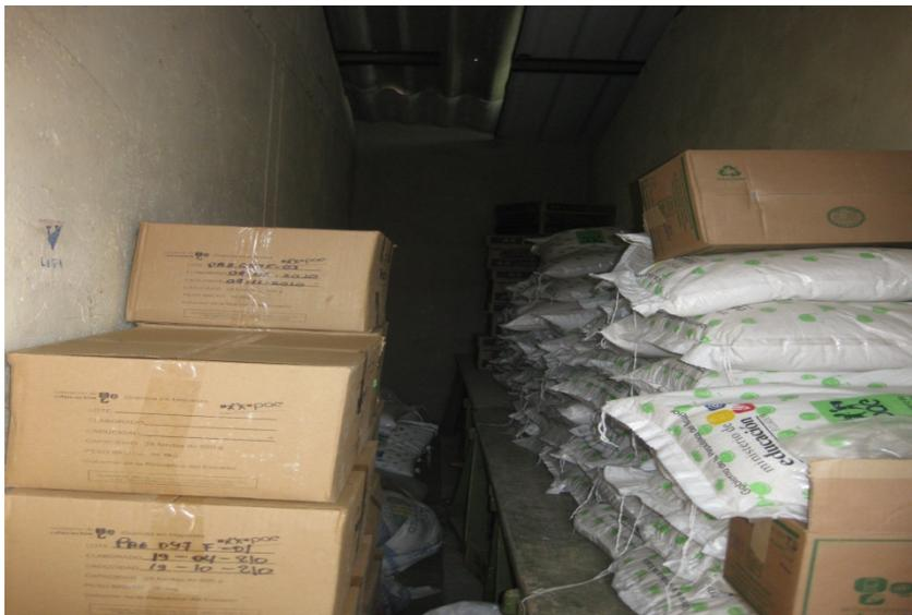
Como se aprecia en la foto existe una ranura en el techo que no evita el acceso de agua lluvia, polvo o basura a los alimentos almacenados
