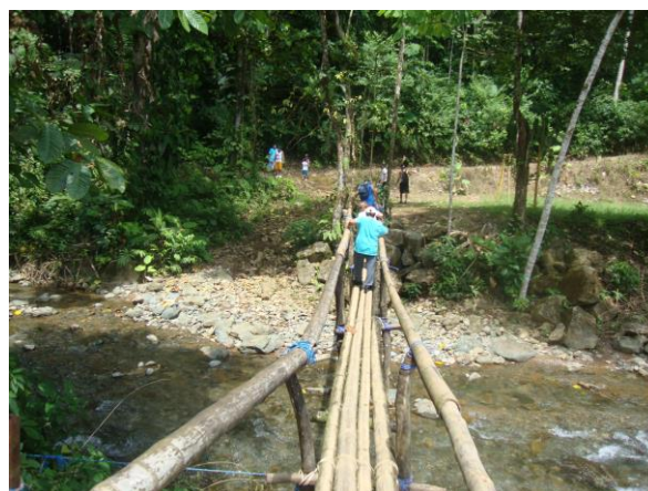
Figura N° 20. Puente de acceso principal a las
